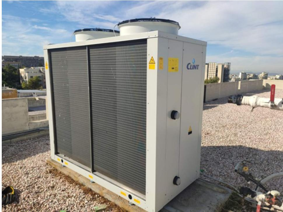
Εγκαταστάθηκε νέα αντλία θερμότητας στο κτίριο Ε της Σχολής Μηχανολόγων Μηχανικών σε αντικατάσταση της παλιάς, εκτός λειτουργίας μονάδας, κατασκευής του 1999.
